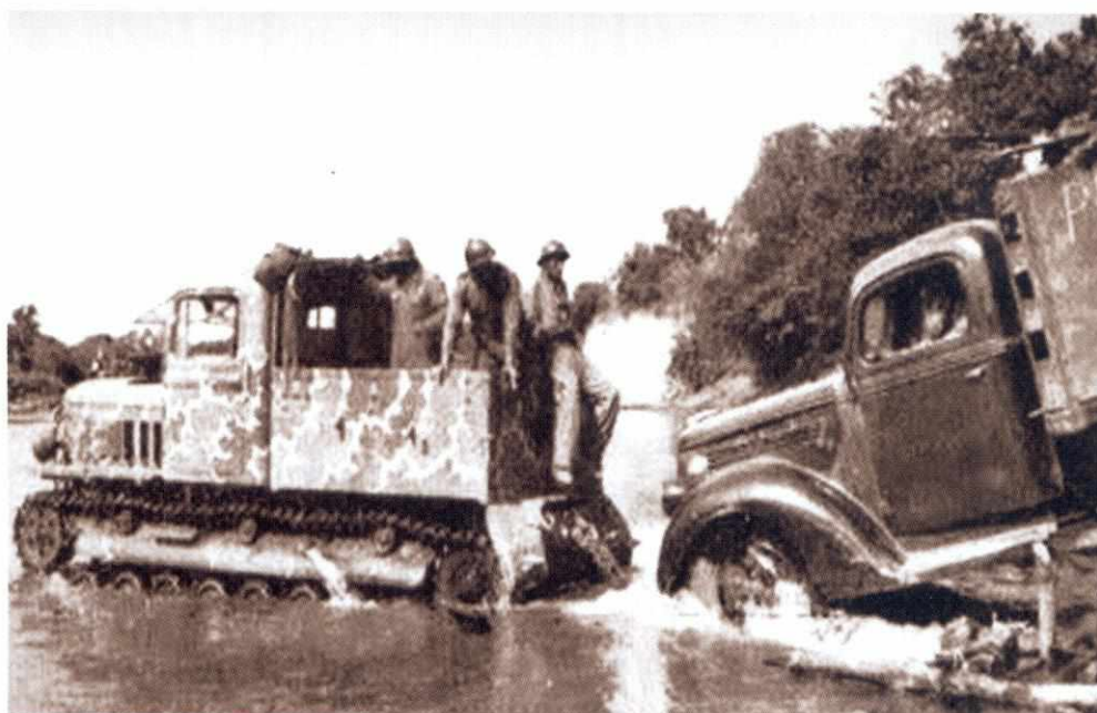
Camión a orugas de recuperación Praga TH, remolcando un camión para vadear el río Zarumilla, en el sector de la Palma, operación que se realizó entre el 25 y 31 de julio, hasta que quedó habilitado un pasaje para camiones.
